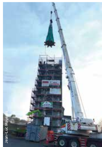
La pose de la flèche sur la tour.
